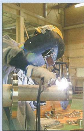
■SUS管溶接中
