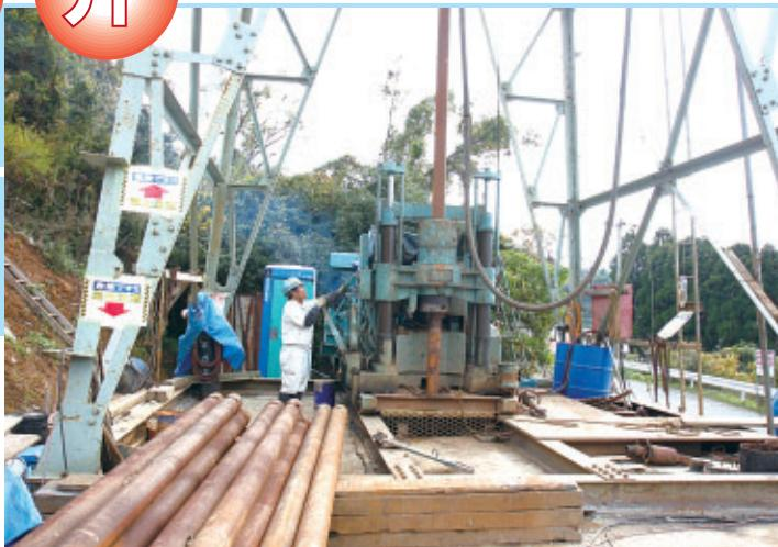
れ 工期の短縮を図る爲に24時間体制での作業を予定しています。今回の温泉掘削に限らず掘削が長尺な深度になると技術的にも精神的にも熟練した技能が要求されます。当社において
