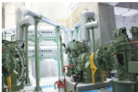
エンジン、排気管、消音器
