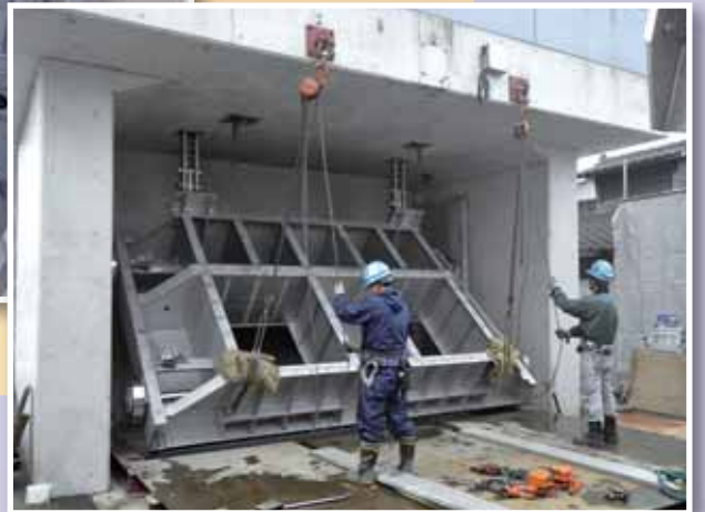
湛水防除事業における排水ポンプ(ゲートポンプ)の据付
