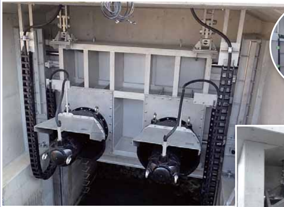
湛水防除事業における排水ポンプ(ゲートポンプ)の据付
